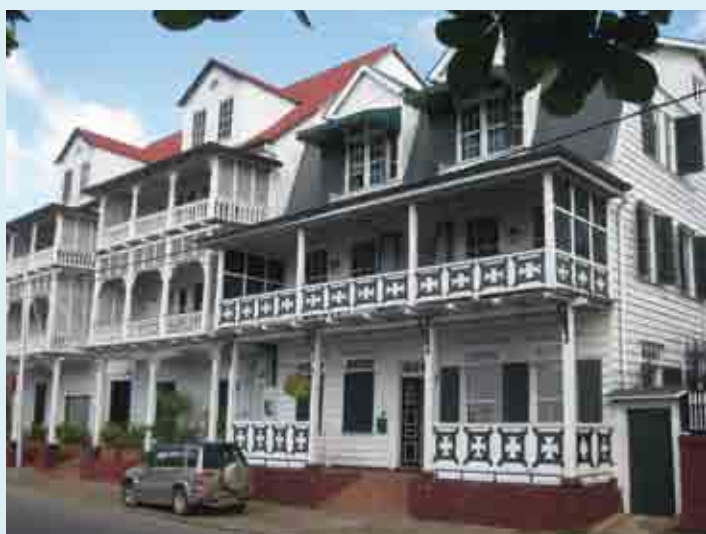
Typische huizen in Paramaribo, hoofdstad van Suriname. Ze lijken een beetje op de Normandische cottagestijl van veel Koksijdse villa's.
