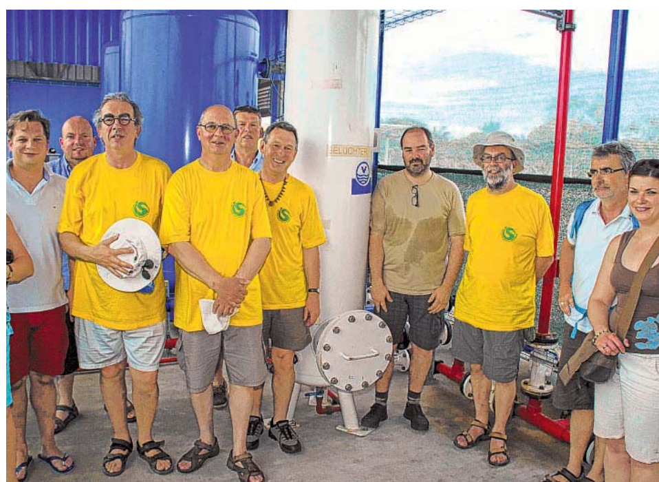
"Eens de watertoren is afgewerkt, zal de installatie voor 100 procent renderen", aldus Frank De Poortere. (Foto EDK)
